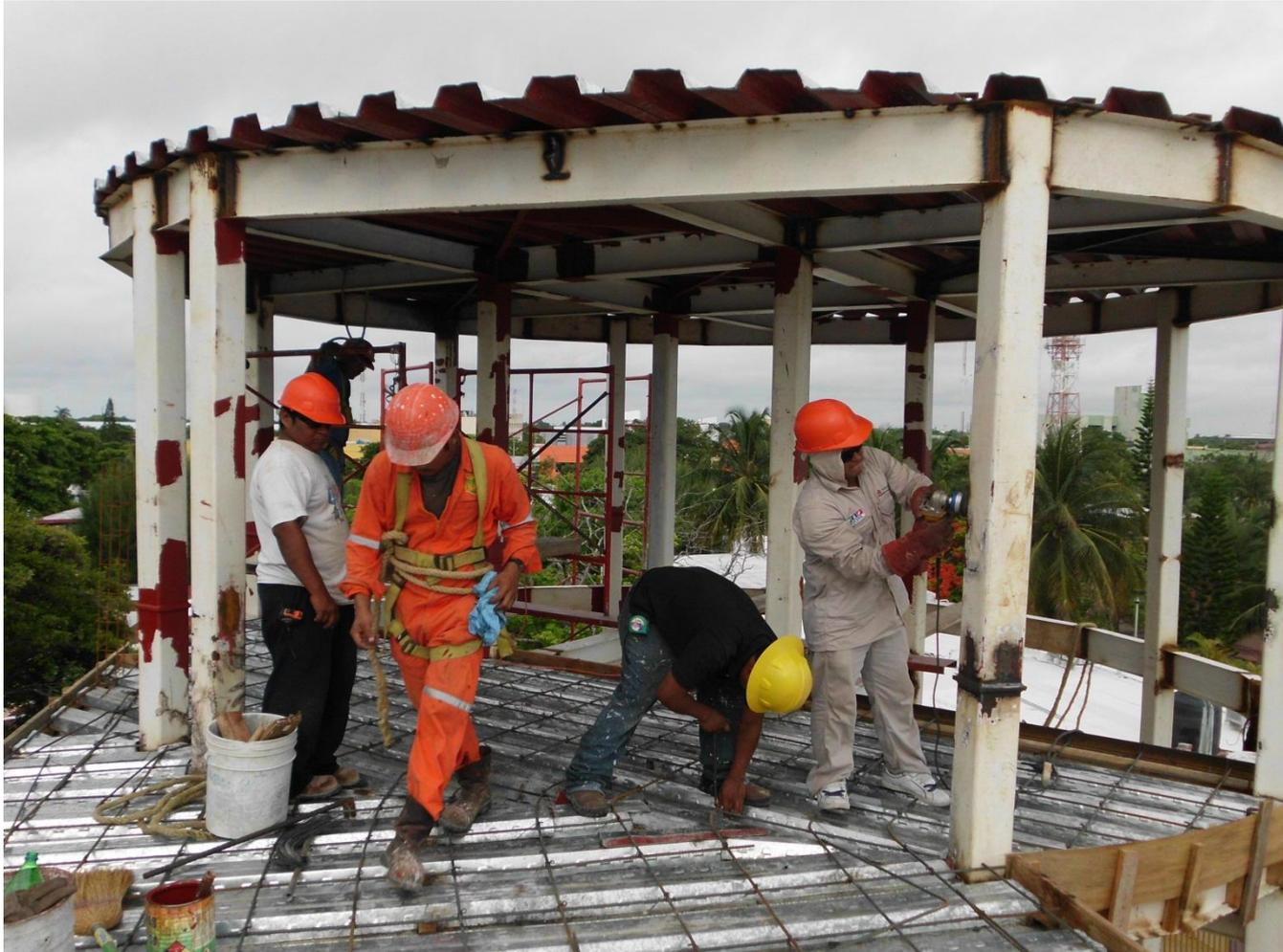
Trabajos de armado en loza de azotea del Edificio de Ingeniería Petrolera.
